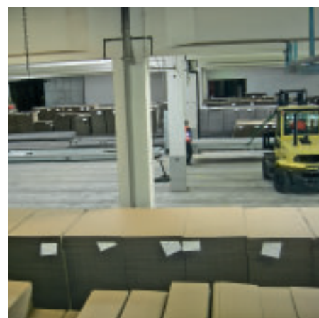
Der Umbau ist in vollem Gange.
