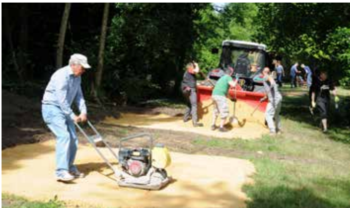
Die Mergel-Fundamente mussten erneuert werden, bevor die Bänke und Tische montiert werden konnten.
