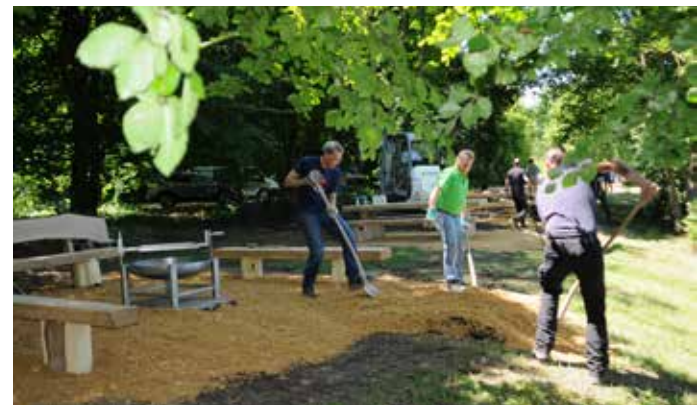
Dank Wetterglück und vor allem der grossartigen Unterstützung schritten die Arbeiten zügig voran.
