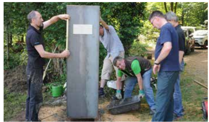
Die neuen Holzlager aus Metall wurden einbetoniert und anschliessend mit dem Holz der alten Bänke ein erstes mal gefüllt.
