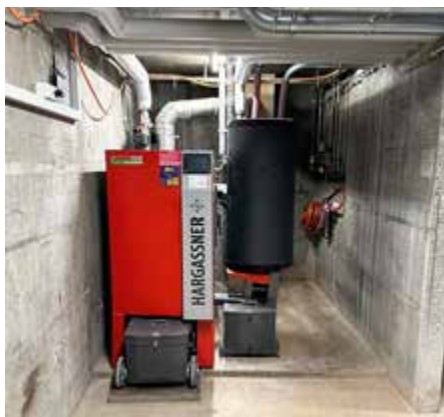
Pelletheizung für Ein- oder Mehrfamilienhaus
